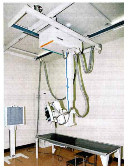
レントゲン室
